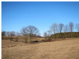
Bild 3: Blick nach Norden auf die Dammraine im Flambachtal
