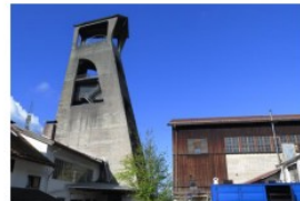
Das Fördergerüst des Klenzeschachts in Hausham.
