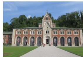
Das Pumpenhaus der Alten Saline in Bad Reichenhall.
