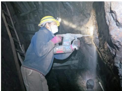
Herstellung von Auflagern mittels Akkubohrhammer
