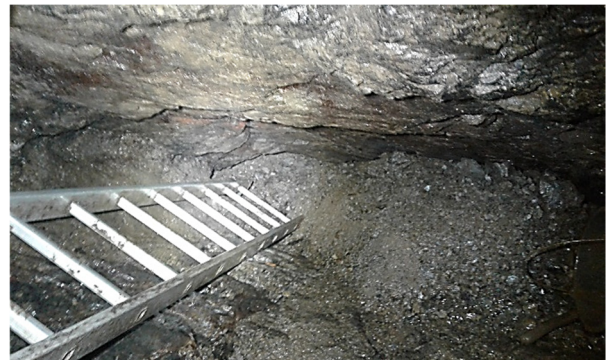
Situation der Schachtaufwältigung bei 12 m u Sohle St. Jürgen Stollen
