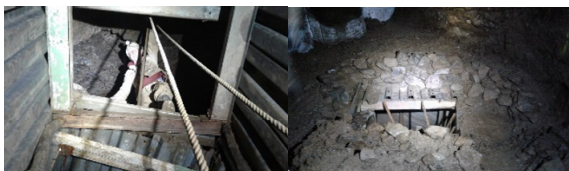
Versatzarbeiten in der Bruchglocke mit letztem Zugang zur neuen Strecke
